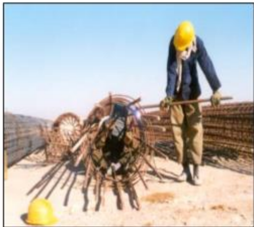
تصویر ۳-۹ و ۳-۱۰ جوشکاری رینگ به قفس آرماتور با اهرم قراردادن آچار F جهت نزدیک کردن رینگ به آرماتور طولی قفس
