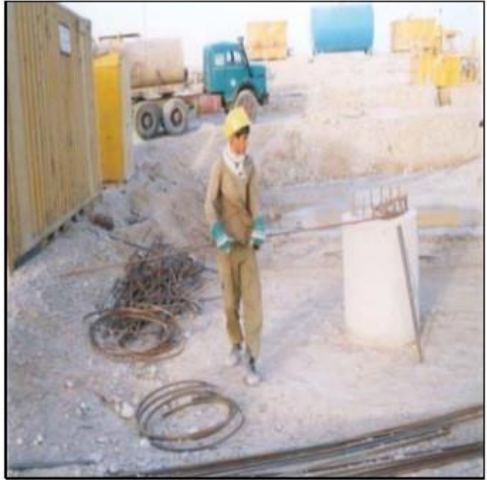
شکل دادن خاموت تنگ بسته با اهرم قرار دادن اچار F در انتهای خلوت
