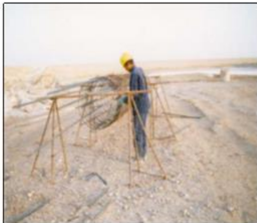
تصویر ۳-۳ و ۳-۴ ساخت قفس آرماتور و کلیه اتصالات آرماتور عرضی به طولی با سیم آرماتوربندی انجام می‌شود
