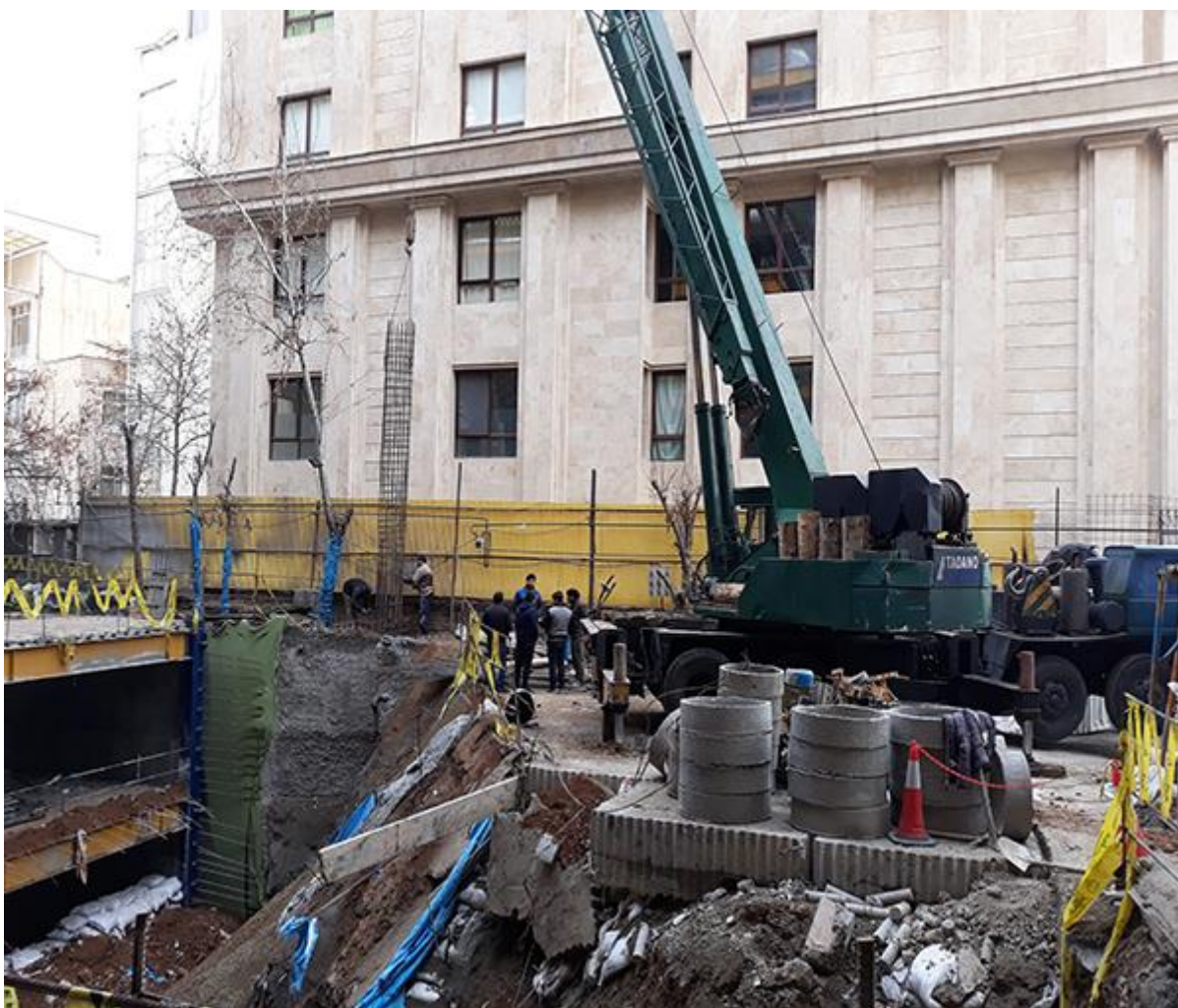
قراردادن قطعه اول قفس آرماتور در چاه شمع
