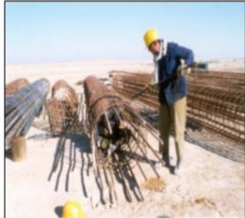
تصویر ۳-۹ و ۳-۱۰ جوشکاری رینگ به قفس آرماتور با اهرم قراردادن آچار F جهت نزدیک کردن رینگ به آرماتور طولی قفس
