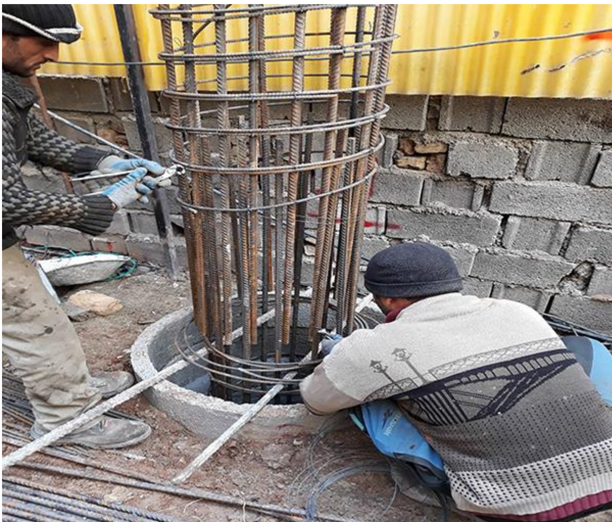
جمع نمودن انتهای قفس آرماتور (برای سهولت در اورب نمودن دو قفس با یکدیگر)
