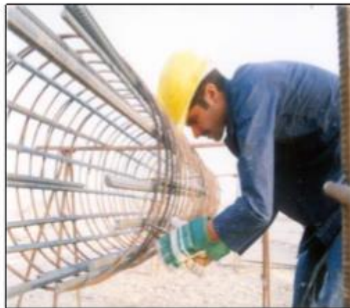
تصویر ۳-۳ و ۳-۴ ساخت قفس آرماتور و کلیه اتصالات آرماتور عرضی به طولی با سیم آرماتوربندی انجام می‌شود
