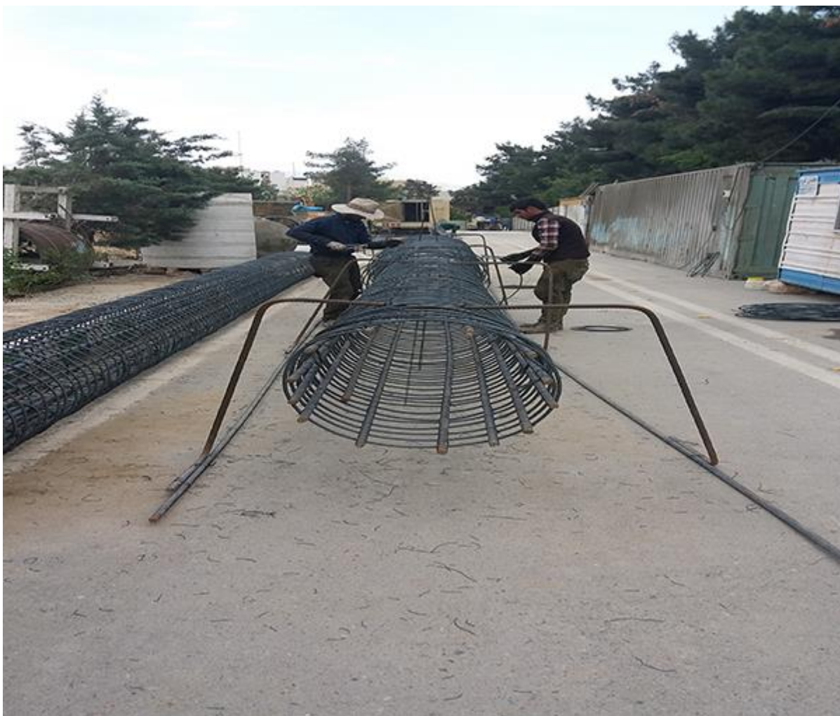
قفس آرماتور آماده شده
