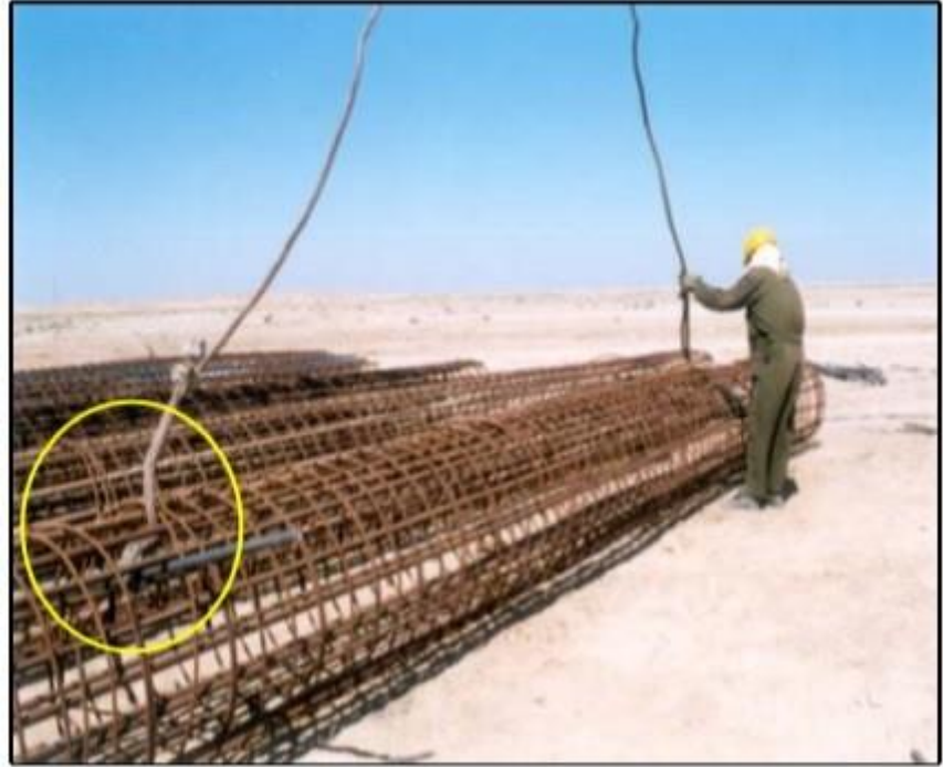
نحوه‌ی اتصال سیم بکسل به قفس آرماتور
