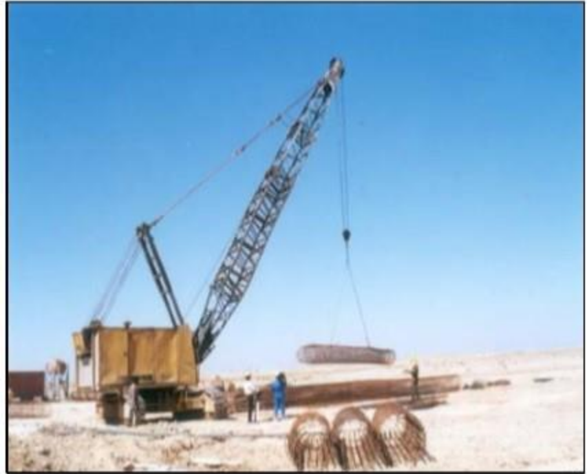
بلند کردن قفس آرماتور با جرثقیل (جهت جابجایی از محل و آماده سازی تا محل نصب در چاه شمع)
