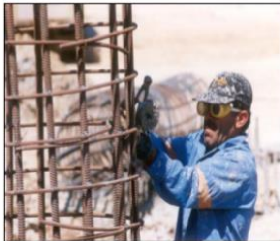
تصویر ۲-۳-۲ بستن اسپیسر سیمانی به قفس آرماتور
