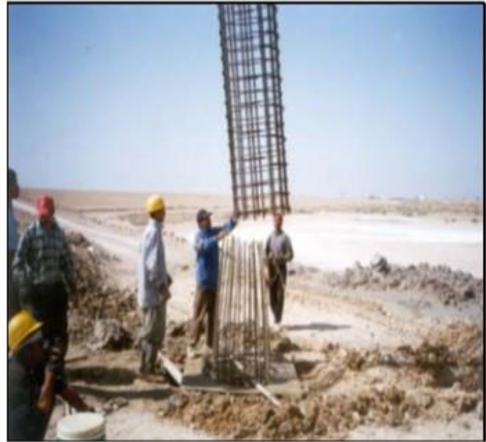
دو قفس متوالی در استانه یکپارچه شدن با یکدیگر
