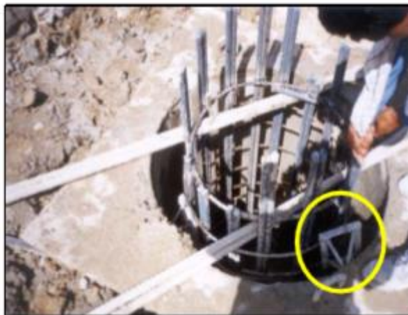
تصویر ۳-۳۳ اسپیسر فلزی را با سیم داخل چاه شمع فرستاده می‌شود
