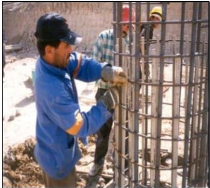
بستن نقاط اتصال آرماتورهای دو قفس به یکدیگر
