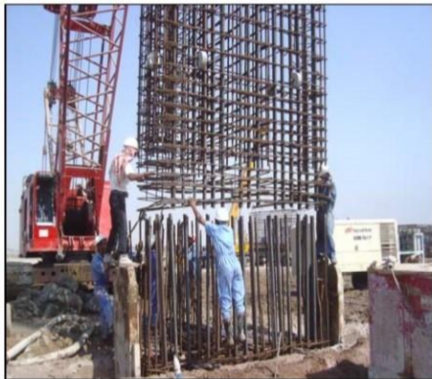
در این تصویر تنظیم و جازدن ارماتورهای انتظار قفس اول درون ارماتورهای قفس جهت اورلب کردن دو قفس برای پانل های T شکل با یکدیگر نشان داده شده است.
