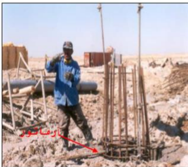
تصویر ۲-۲۳ آرماتور افقی جهت تحمل و انتقال وزن قفس آرماتور به زمین
