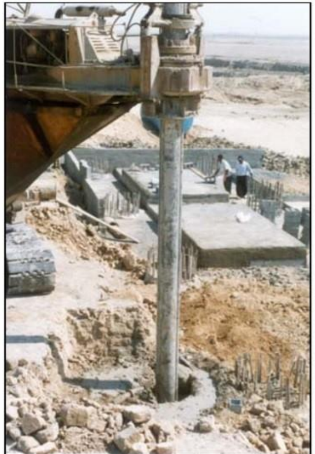
در این تصویر محل اتصال کلی به باکت مشخص شده است
