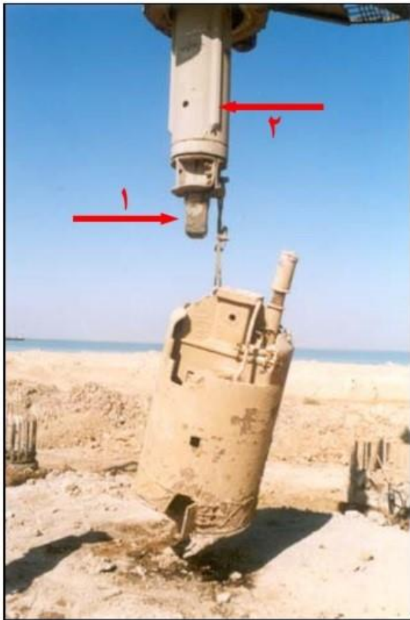
نمایی از کلی حین حفاری که به داخل چاه شمع فرستاده شده است
