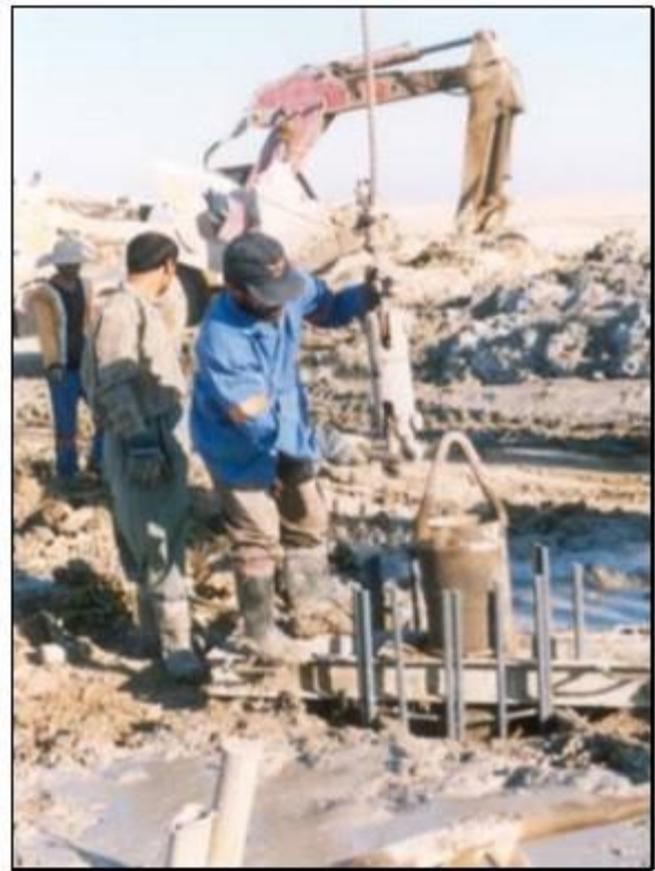
ازاد نمودن قلاب جرثقیل و انتقال وزن لوله ترمی آویزان در چاه شمع به جک
