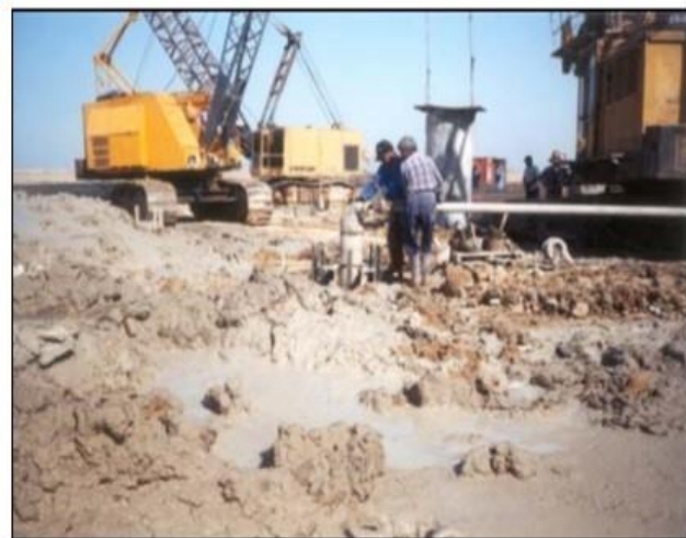
اتصال لوله پرو به کلاهک زانوئی سر لوله ترمی
