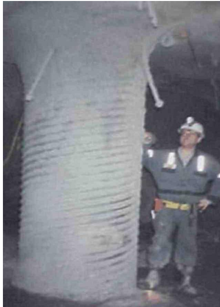
شکل 1-5- روکش کردن پایه پلها
