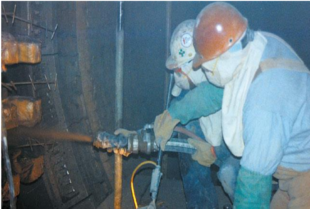
شکل 1-6- لا ینینگ تونلها و افزایش ضخامت لوله های بتنی در محیط های خورنده و خطر ناک در مقابل آتش
