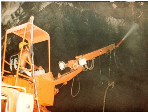
شکل 1-11- نوعی رباط برای اجرای شاتکریت که بر کامیونی تعبیه شده است و برای اجرای شاتکریت در تونلهای بزرگ بکار می رود.
