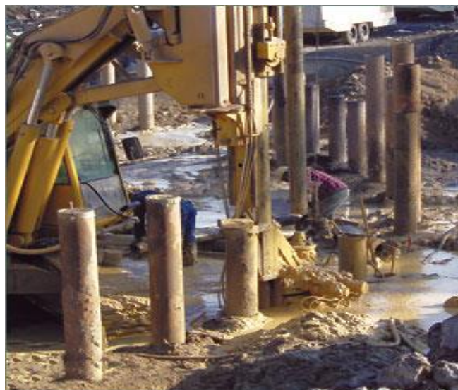
تصویر 1-3 : اجرای میکروپایل ها با سطح آب بالا
