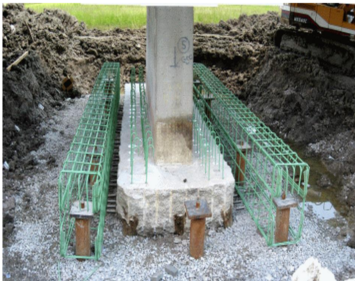
تصویر 4-1 : اجرای میکروپایل ها در کنار پایه پل
